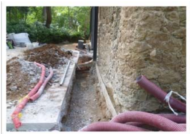
Rasa 4000. Sector al costat de l'accés lateral al parc pel carrer Olot.
