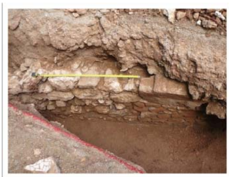
Detall de l'alçat ( UE 2011) amb la reparació de maons (UE 2014).
